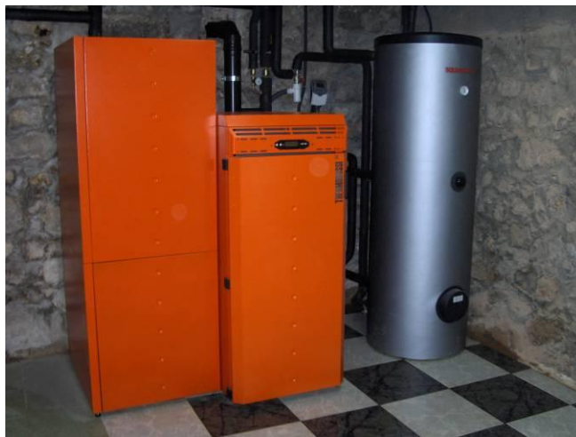
Fig. 7.1. Instal·lació de biomassa domèstica amb acumulador d'inèrcia.
