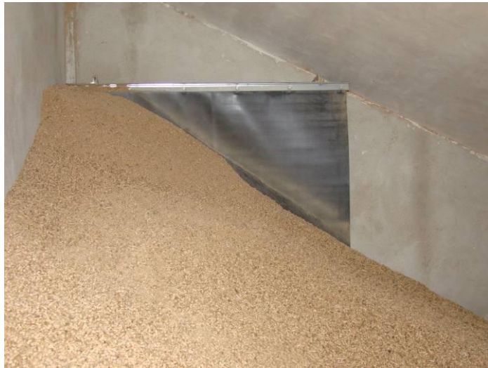
Fig. 2.5. Detall de l'interior d'una sitja on s'aprecia la lona amortidora juxtaposada a l'entrada del pèl-let i que evita que impacti contra la paret de formigó.
