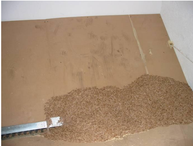
Fig. 5.4 Interior d'una sitja d'obra on s'aprecien les rampes a 45° d'inclinació i el vis sense fi que extreu el pèl-let i el condueix a l'alimentació de la caldera
