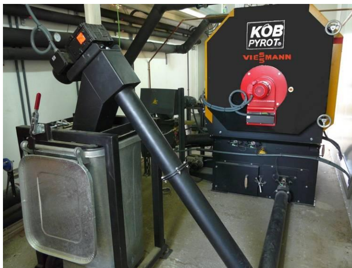
Fig. 6.3. Sistema de recollida de cendres d'una caldera de gran potència. Es pot observar com un vis sense fi porta la cendra produïda a la caldera a un cubell habilitat amb aquesta finalitat.
