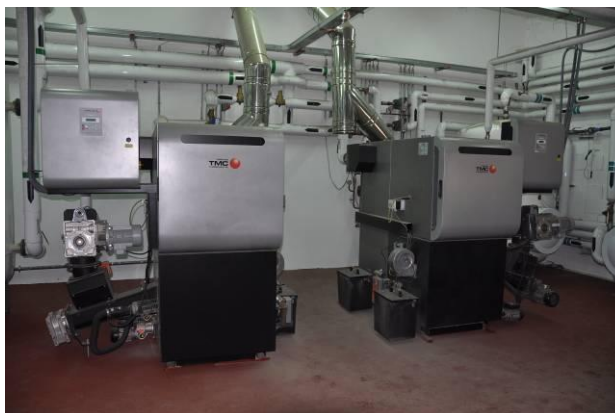
Fig. 3.3. Local tècnic d'un edifici de serveis, amb dues calderes de biomassa en paral·lel de 85 kW cadascuna, prou per a cobrir fins a un 70% de la punta de demanda tèrmica de l'edifici.
