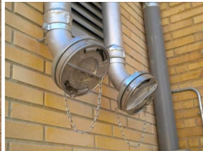
Fig. 2.24. Detall del sistema d'alimentació - anada i retorn- de la sitja per càrrega pneumàtica.
