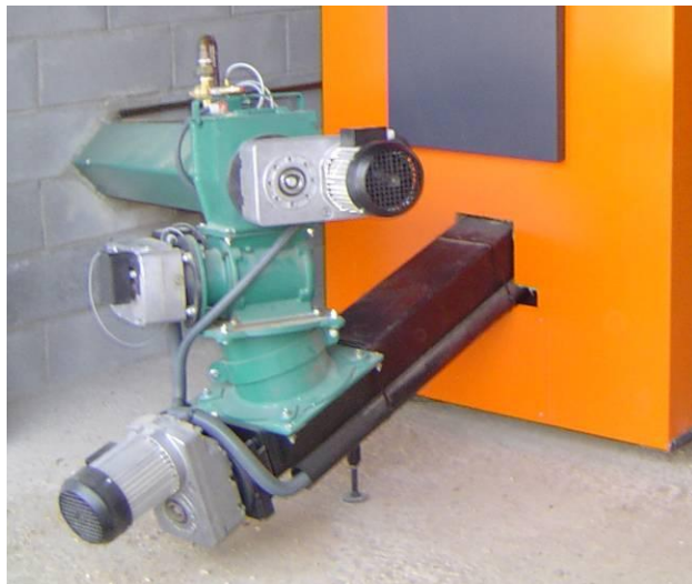
Fig. 4.2. Alimentació d'una caldera d'estelles. Es pot apreciar el vis sens fi (superior) que, provinent de la sitja, alimenta el vis propi de la caldera (inferior) i que modula l'entrada del combustible al cremador. El vis sens fi per estella és sensiblement més gran que el de pèl·let.
