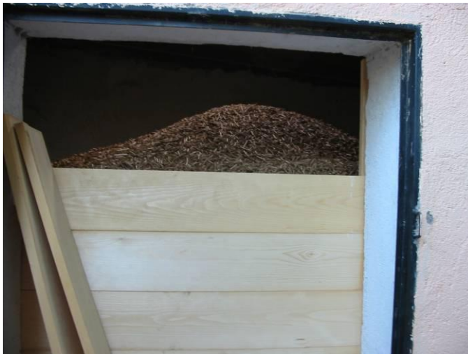
Fig. 5.5. Accés a una sitja d'obra. Les fustes són sempre necessàries per possibilitar el registre quan la sitja està carregada totalment o parcialment.
