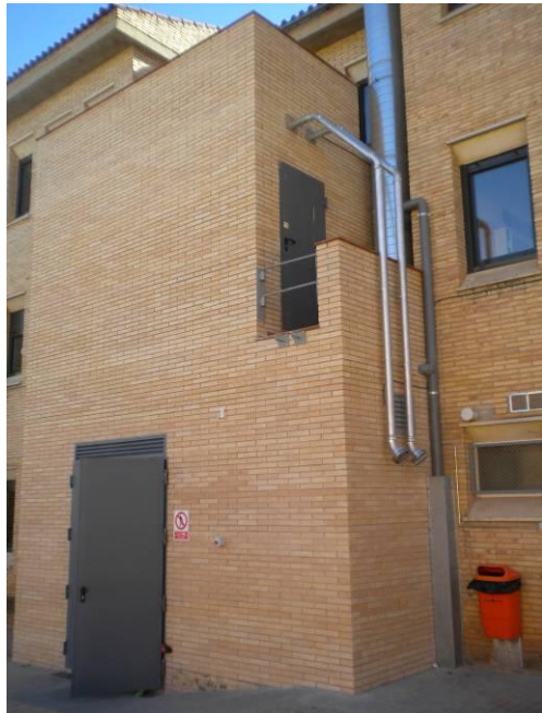
Fig. 2.24. Detall del sistema d'alimentació - anada i retorn- de la sitja per càrrega pneumàtica.
