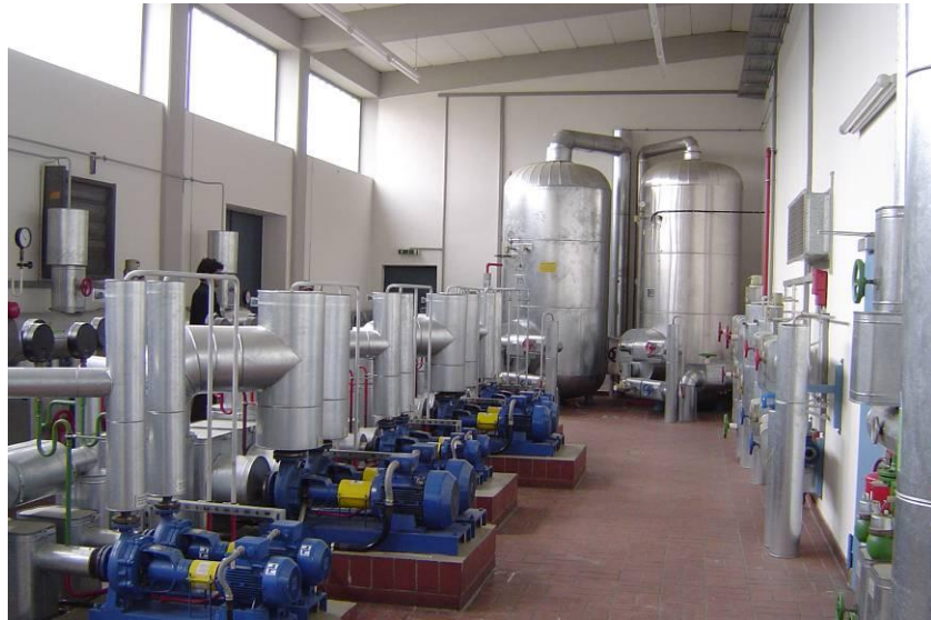
Fig. 3.4. Sistema d'acumulació i distribució de l'energia d'una instal·lació de calefacció de barri.
