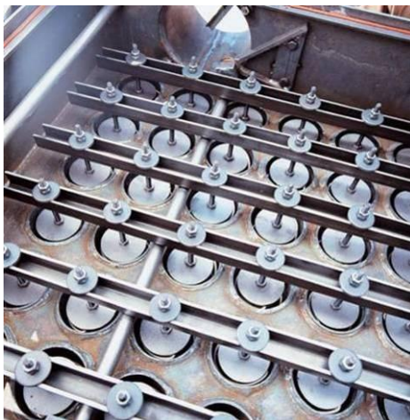
Fig. 6.1. Vista superior de la sortida de fums del bescanviador d'una gran caldera de biomassa, en què es poden apreciar els turbuladors, encarregats de fer caure la cendra i augmentar el rendiment de bescanvi del conjunt.
